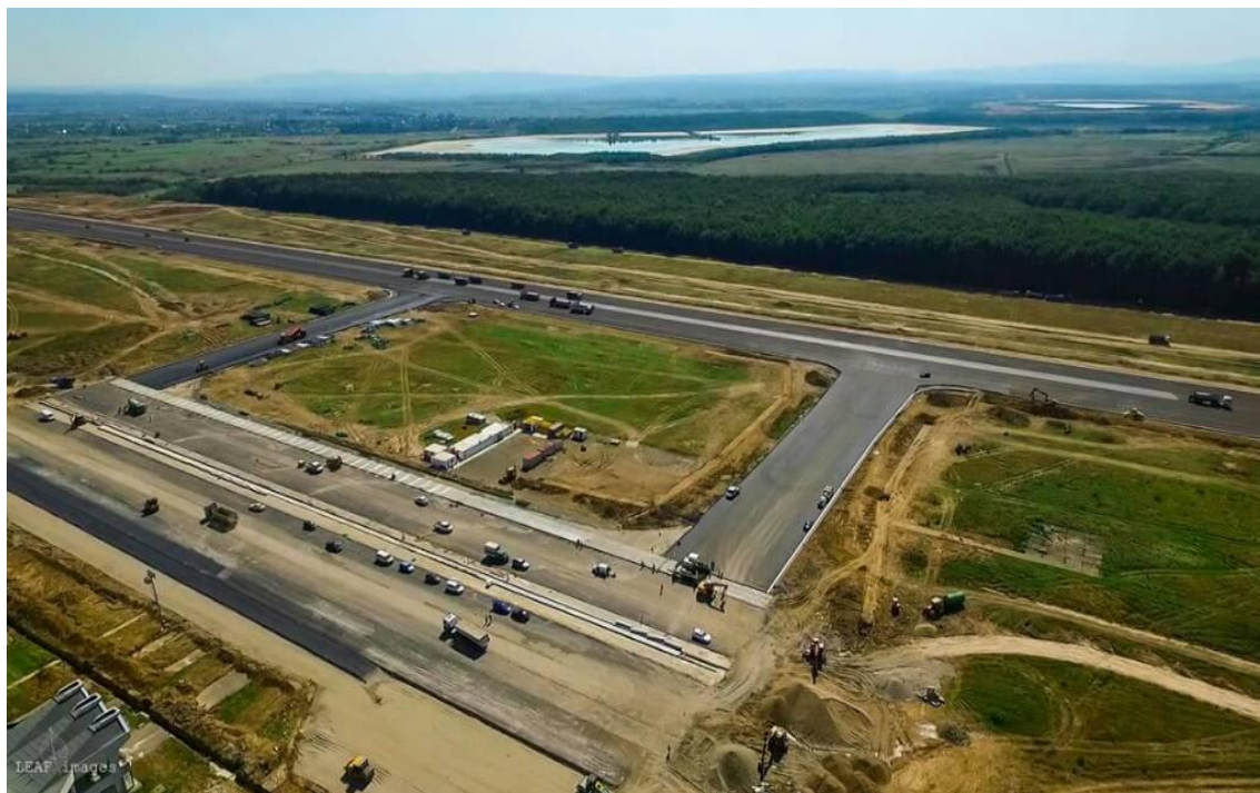
Figura 59. Lucrările de construcție a platformei de staționare a aeronavelor din cadrul AIMM
