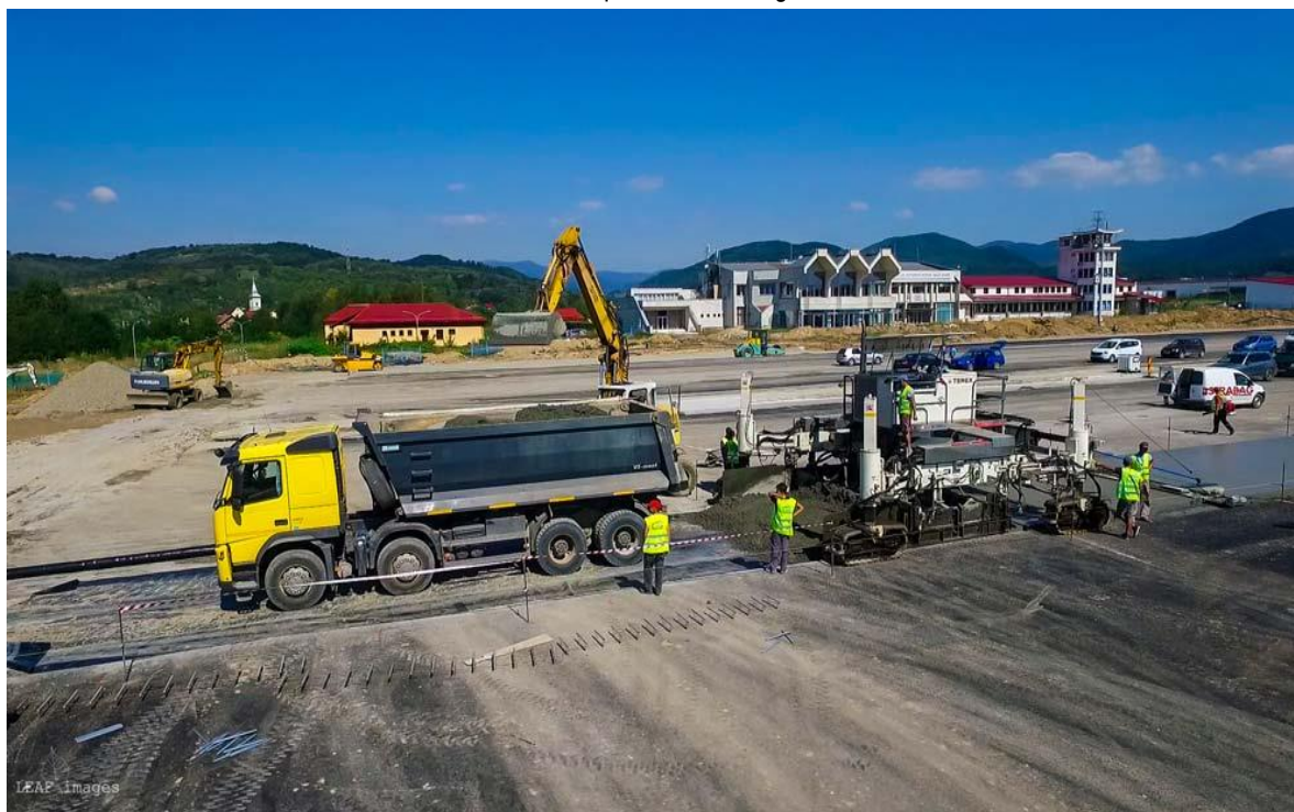
Figura 53. Lucrările de extindere a pistei din cadrul AIMM – procesul de turnare a stratului de beton
