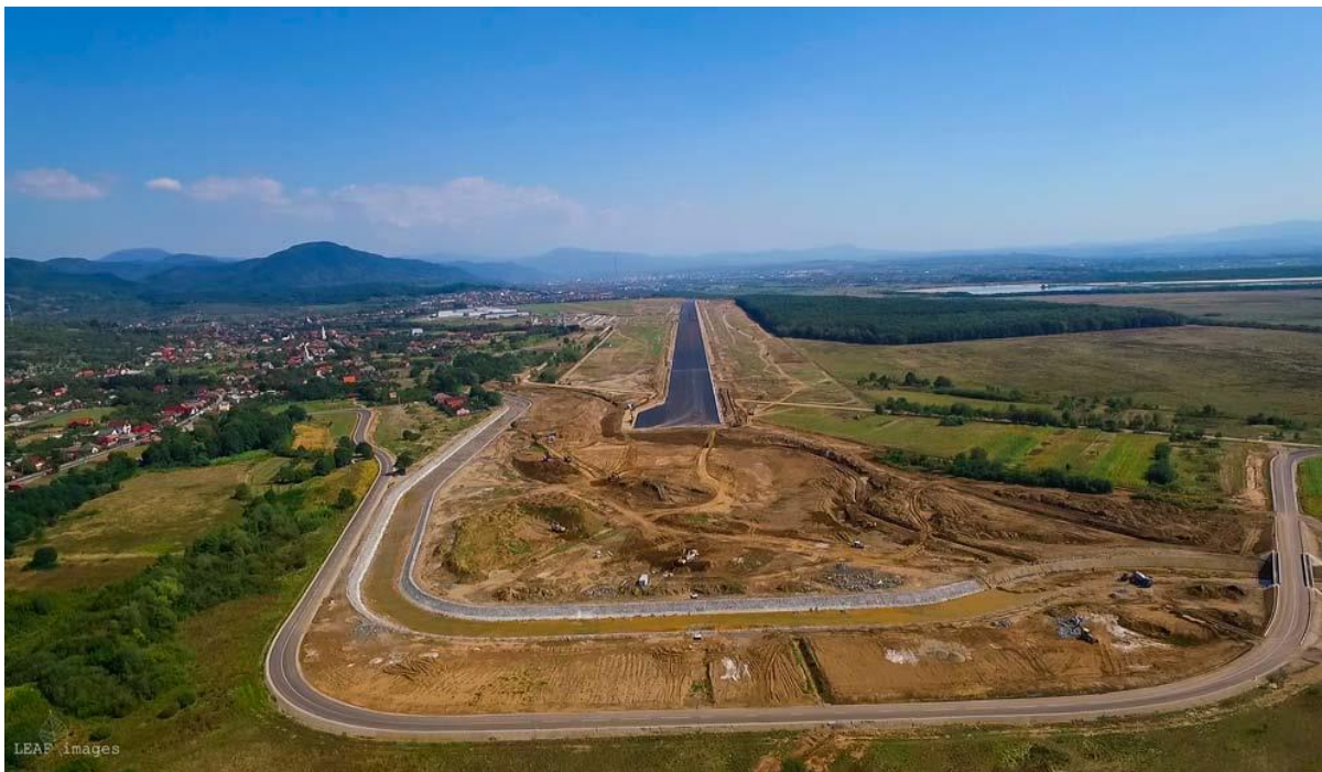
Figura 55. Lucrările de relocare a cursului râului Băița în vederea extinderii pistei aeroportuare din cadrul AIMM – imagine panoramică
